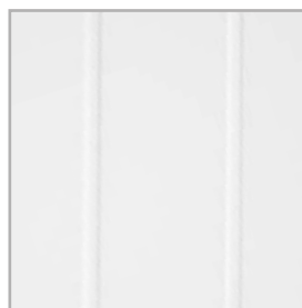
frézování na povrchu křídla
