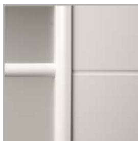
pohled na frézování
