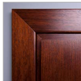
spojování lišt pod úhlem 45°
